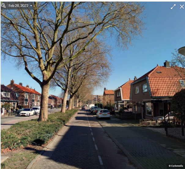
Noorderstraat, NO-richting (voor reconstructie)
